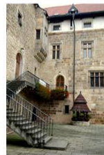
schodiště s dnešním hlavním vstupem
