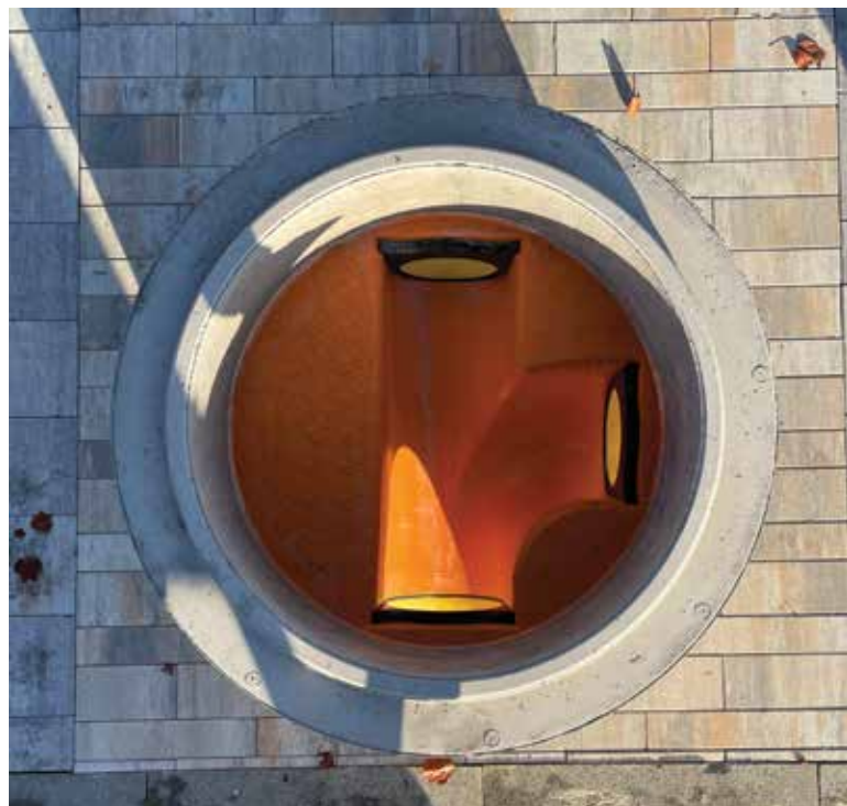
Betonsko okno sa integrisanom plastičnom kinetom
