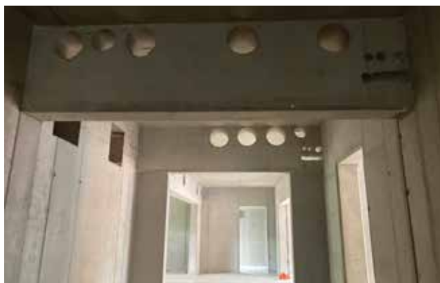
Slika 8: RCK „Ruđera Boškovića“, Zagreb, betonski i instalacijski brutalizam - vidljivi beton u središnjem hodniku s rupama za ventilacijske kanale i druge instalacije, prvi montirani elementi ventilacije, 2023., u izvedbi, autori Lj. i M. Mišćević
