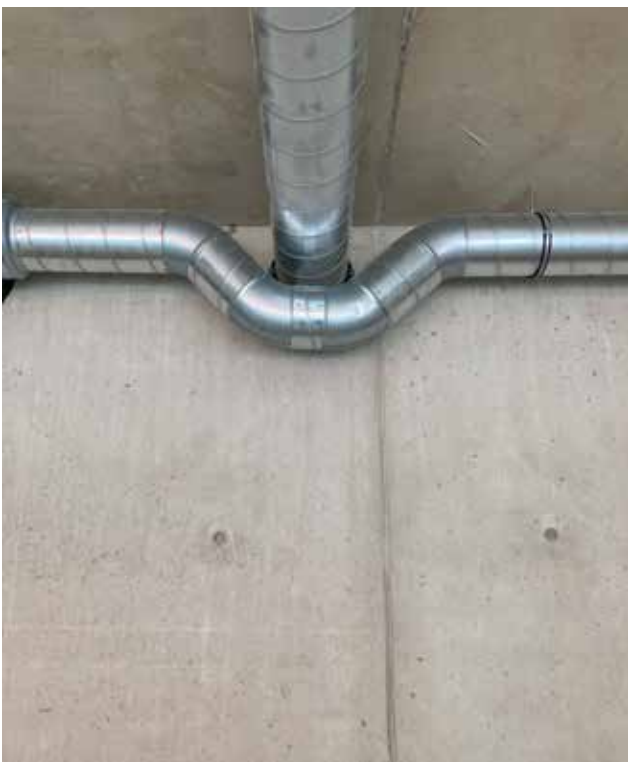
Slika 8: RCK „Ruđera Boškovića“, Zagreb, betonski i instalacijski brutalizam - vidljivi beton u središnjem hodniku s rupama za ventilacijske kanale i druge instalacije, prvi montirani elementi ventilacije, 2023., u izvedbi, autori Lj. i M. Mišćević
