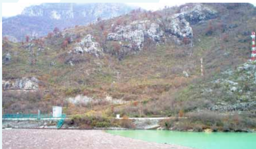
Plastična ambalaža ispred brane na jezeru Grabovica
